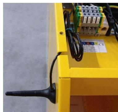
Antenna GPRS - posizionamento definitivo esterno alla macchina
